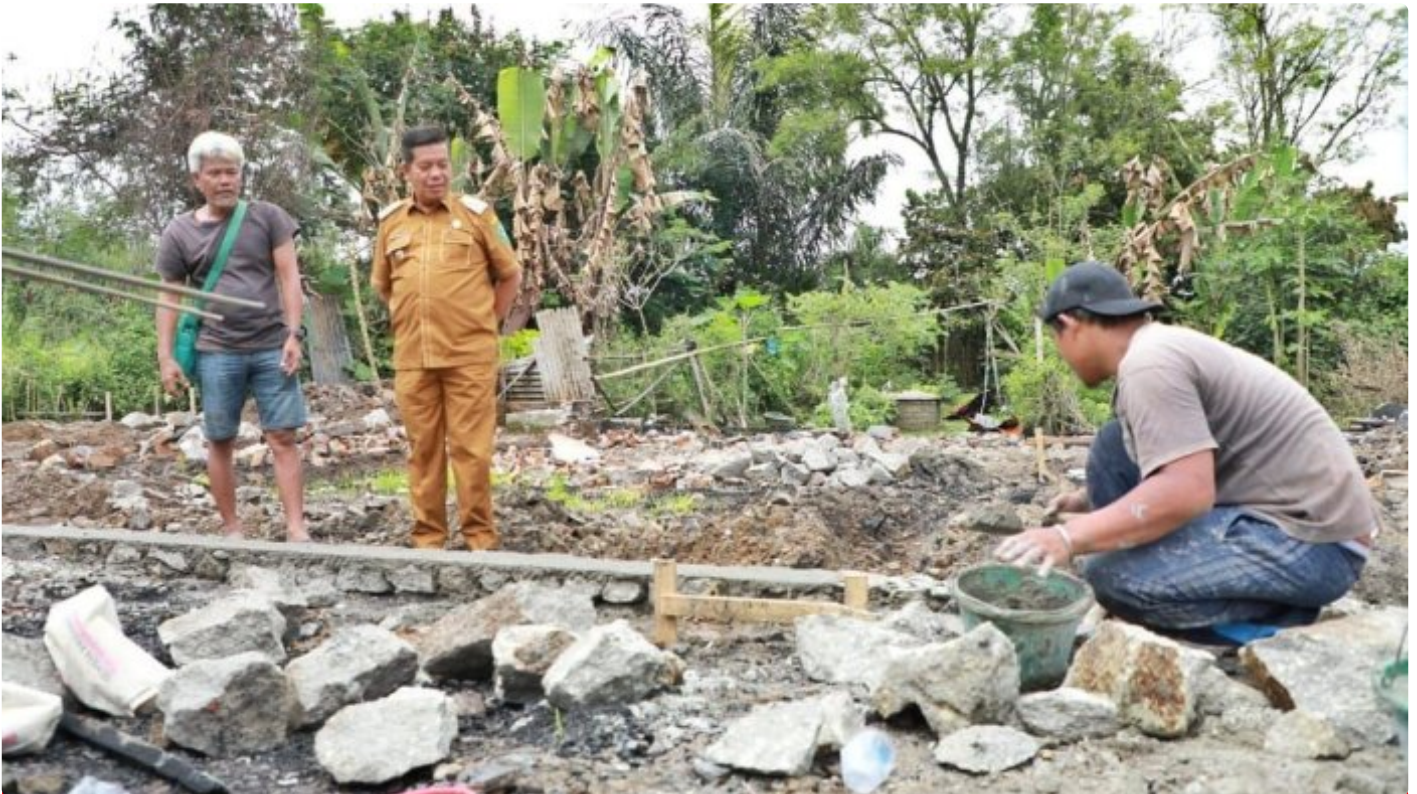
Bupati Simalungun Radiapoh Hasiholan Sinaga saat meninjau pelaksanaan pembangunan ke 7 rumah milik warga
